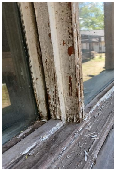
Foto. 3 Obraz zniszczenia stolarki od zewnątrz.
