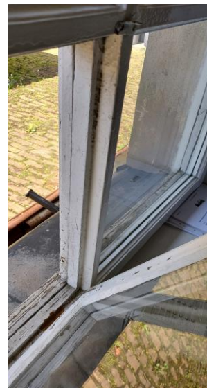
Foto. 4 Obraz zniszczenia stolarki od wewnątrz.
